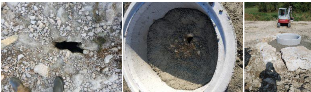
Ci-dessus: avant et après aménagement d'un siphon
