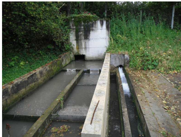
Vue sur le site du rejet de la STEP.
