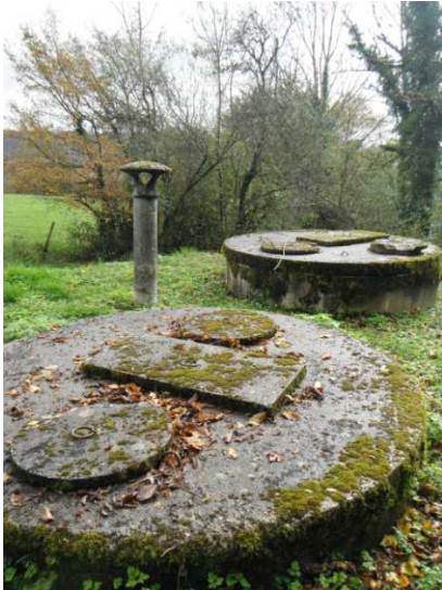
Aspect extérieur de la STEP.
