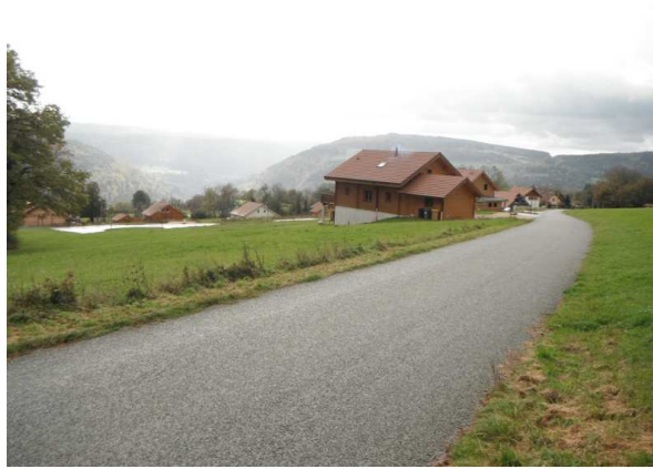
Vue sur les nouveaux lotissements du Saucet.
