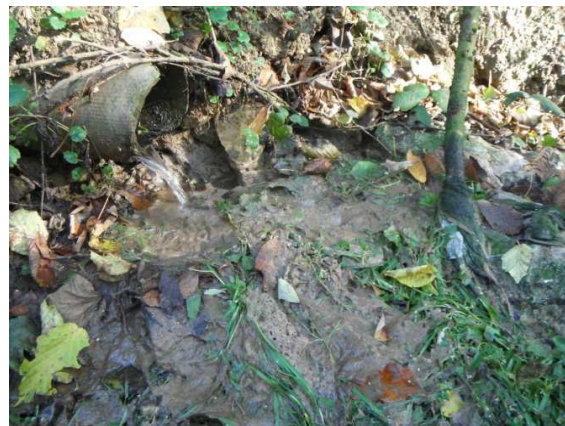
Le rejet des eaux traitées.
