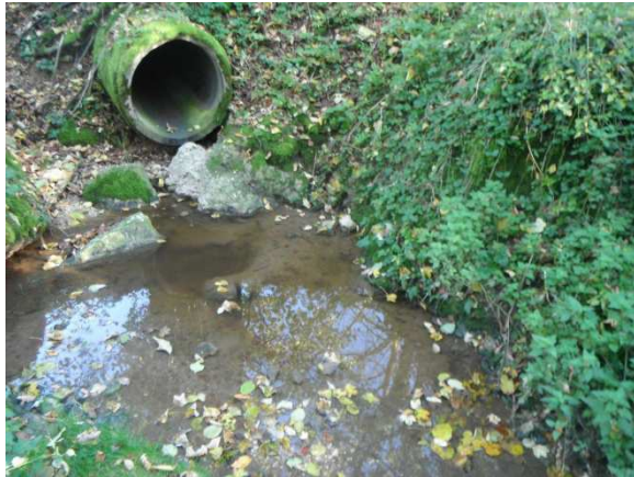
Le très probable déversoir d'orages.
