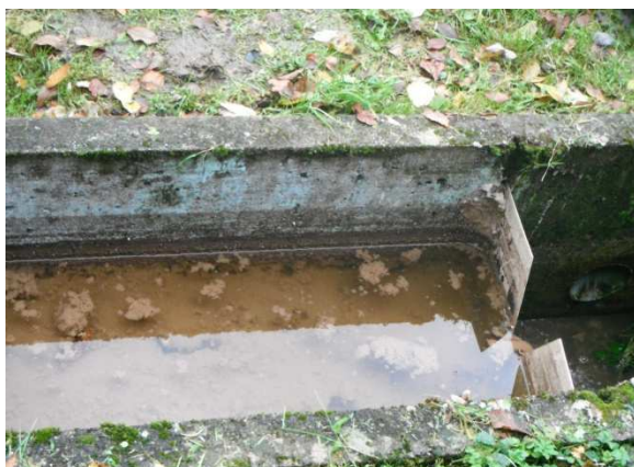
Le canal de fuite vers l'exutoire.
