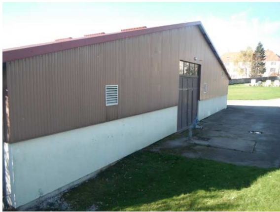
Vue sur le bâtiment de la STEP.
