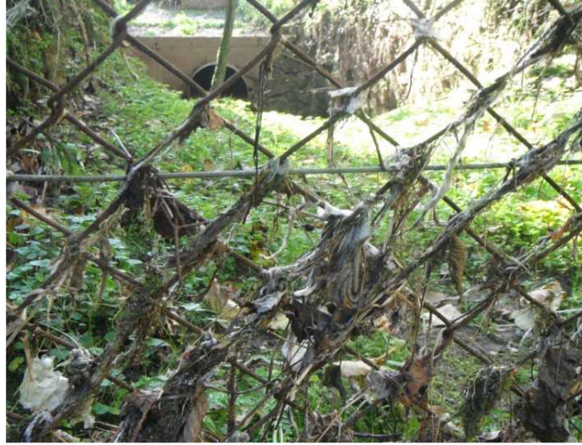
Exutoire du gouffre : « grillage-dégrilleur »...
