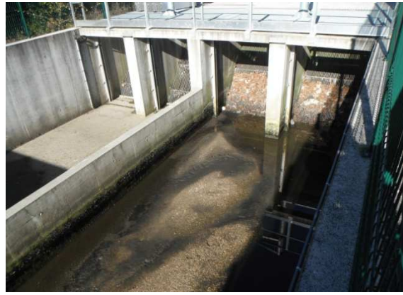
Le décanteur avec les arrivées d'eau (à gauche) et le dégrilleur de sortie (à droite).
