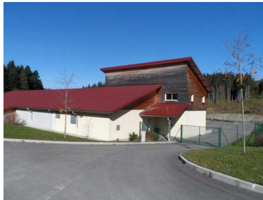
Vue sur le bâtiment neuf abritant la STEP.
