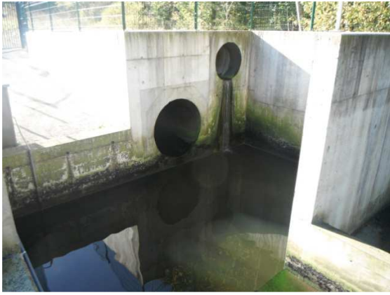
Le décanteur avec les arrivées d'eau (à gauche) et le dégrilleur de sortie (à droite).
