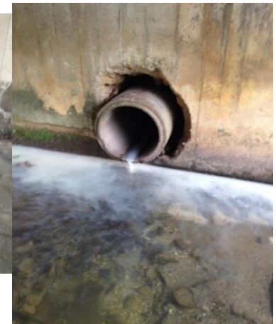
Seloncourt/ 2-4 rue des Carrières, sous le pont / Un rejet continu d'eaux très turbides grises bleutées coule de ce DO avec par moment des éléments plus gros d'origine domestique
