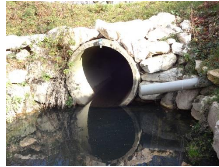
Etupes/ Un rejet d'eaux turbides, huileux par temps sec, en sortie du DO
