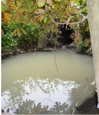
Courcelles lès Montbéliard/ Un rejet continu d'eaux très turbides, par temps sec, à priori des mauvais branchements de la Petite Hollande
