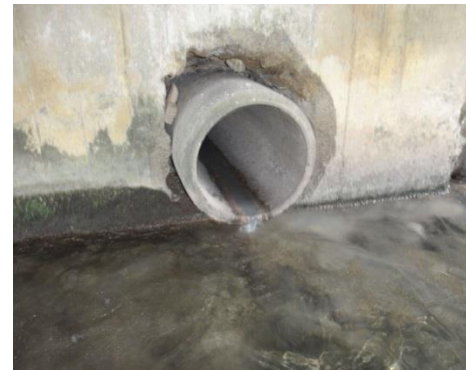
Seloncourt/ 2-4 rue des Carrières, sous le pont / Un rejet continu d'eaux très turbides grises bleutées coule de ce DO avec par moment des éléments plus gros d'origine domestique
