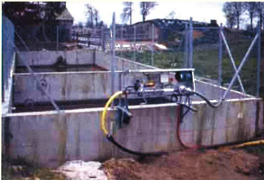
Photo 3 - Bassin tampon et de sédimentation dimensionné avec un stockage pour épandre sur sol ressuyé.
