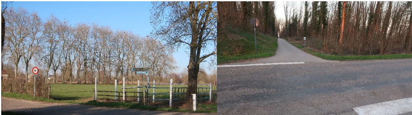
Photos 78 à 79 : aménagement de la véloroute (secteur de Rigny et de Savoyeux) – mars 2021 Un marquage au sol et des dispositifs de protections minimales
