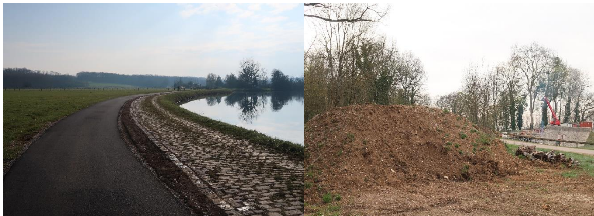
Photos 47 et 48 – secteur Rupt-sur-Saône et Ovanches. Aménagement de la véloroute en 2020.
