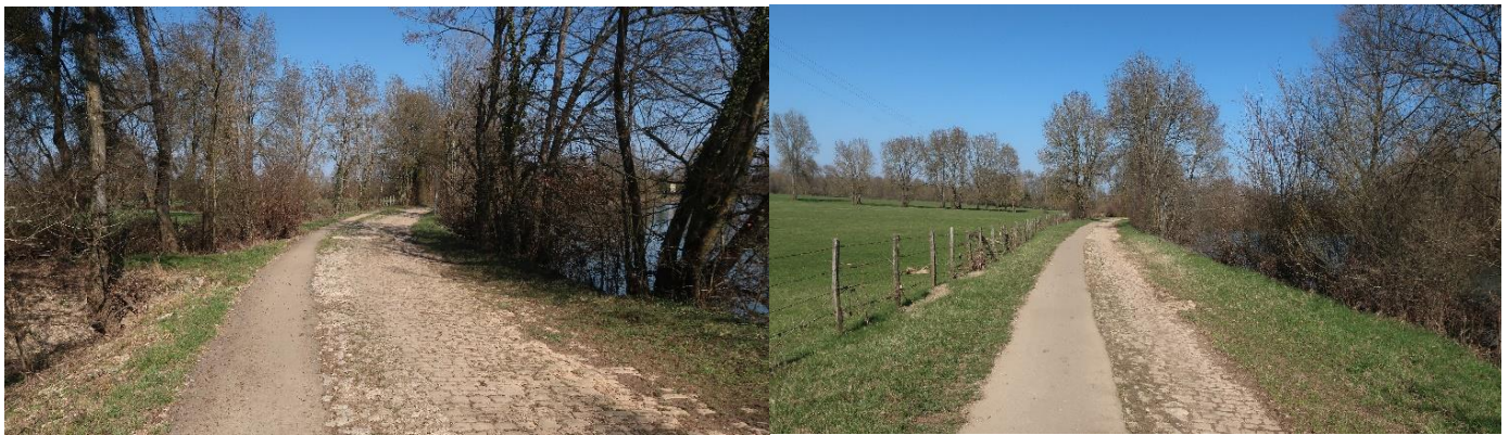
Photos 51 et 52 – section Auxonne – Pontailler-sur-Saône de la V50 (département de Côte d'Or - mars 2021) Chemin de halage pavé préservé. Le bitume couvre entre 30 et 50% de la voie pavée
